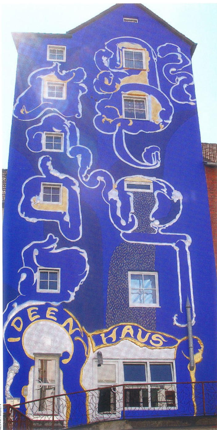
Der blaue Turm – ein neuer Blickfang im Stadtbild von Hollfeld und ein weiteres künstlerisches Projekt des „alternativen“ Bauunternehmers Hans Stenglein.
